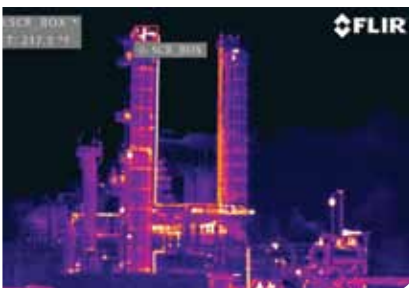
FCシリーズRは、特定エリアの温度監視が可能。事前に設定した温度に到達または超えると、Eメール、デジタルアウトプット、VMSなどのアラームで通知する。
